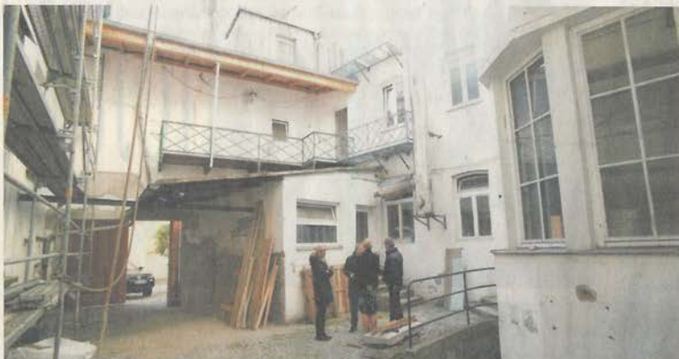
Viel Arbeit steckt hinter der Sanierung des Hotels.
