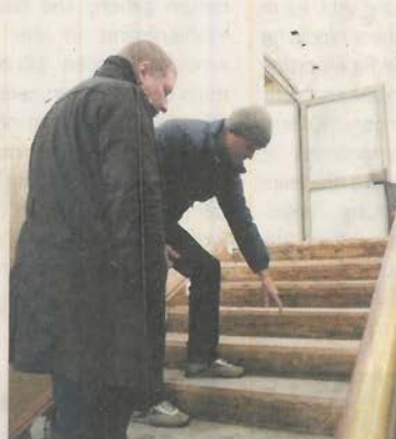
Ein besonders kniffliges Projekt: die Sanierung der Treppe.
