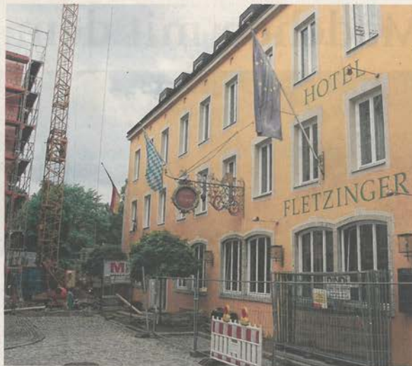
Noch wehen die alten Fahnen am Hotel hinterm Bauzaun. Ab November wollen die neuen Besitzer hier wieder Gäste begrüßen.
